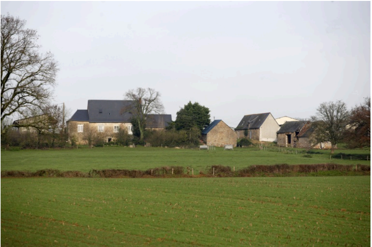
Vue d'ensemble depuis le chemin de la Renouardière au sud.
