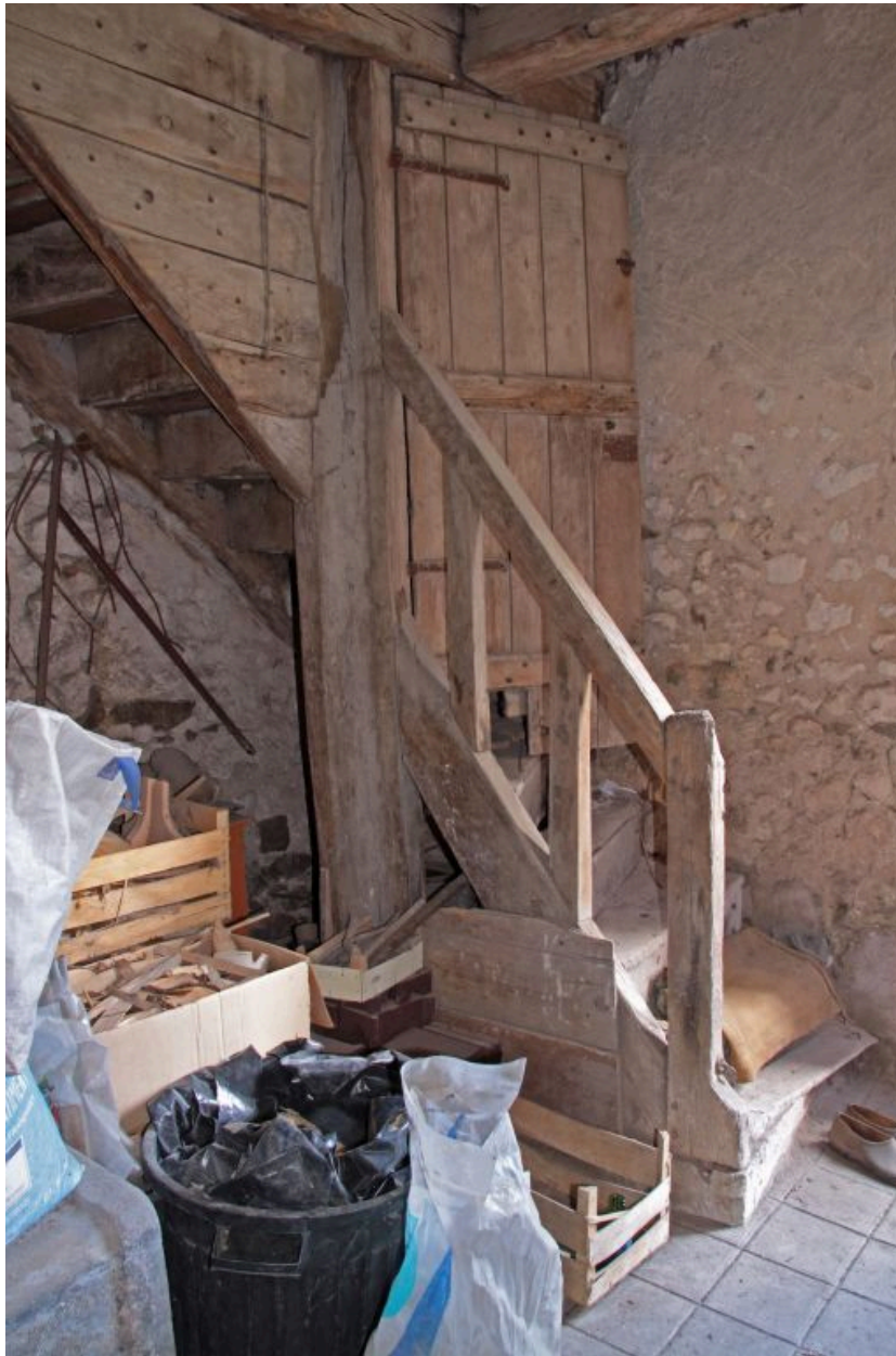
Les communs : escalier.
