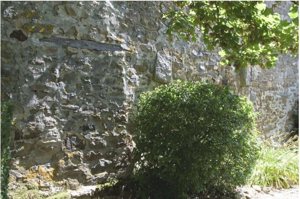
Le pignon sud-ouest du logis : la base du mur.
