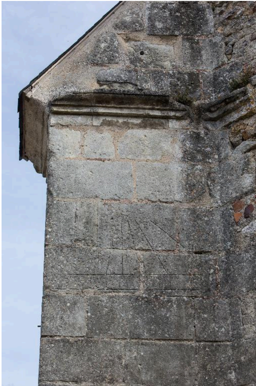
Tour-clocher, contrefort sud-ouest, détail : vestiges d'un cadran solaire sur la face est.
