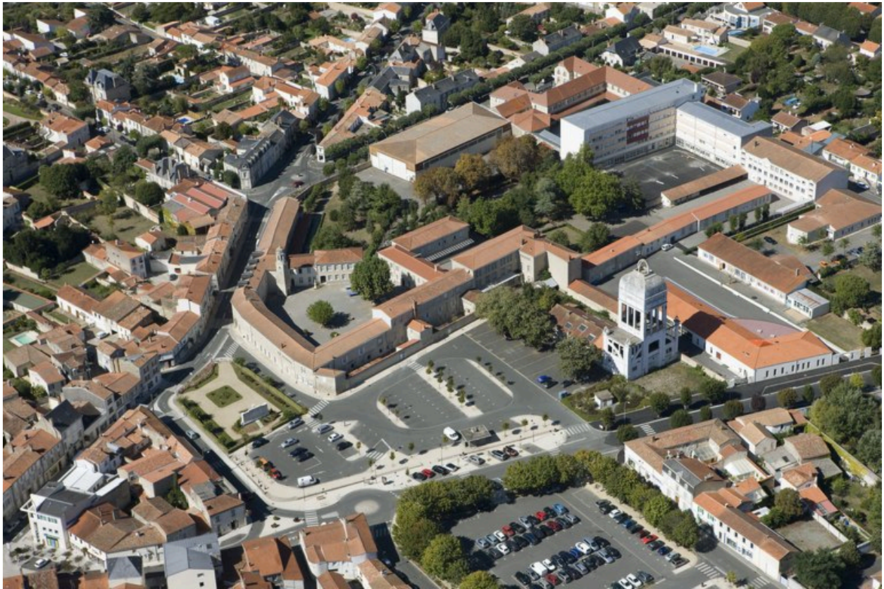
Vue aérienne prise du sud-est.
