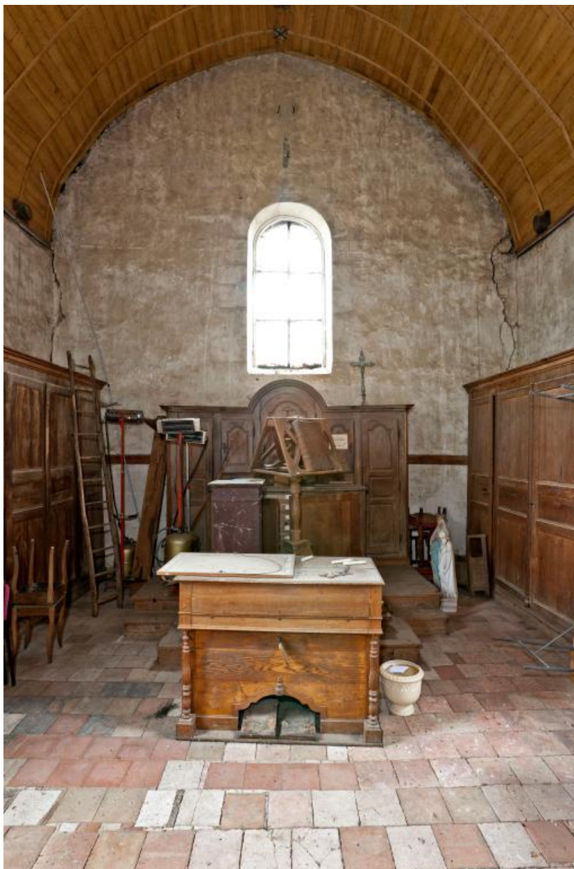
Sacristie. Vue du mur sud.
