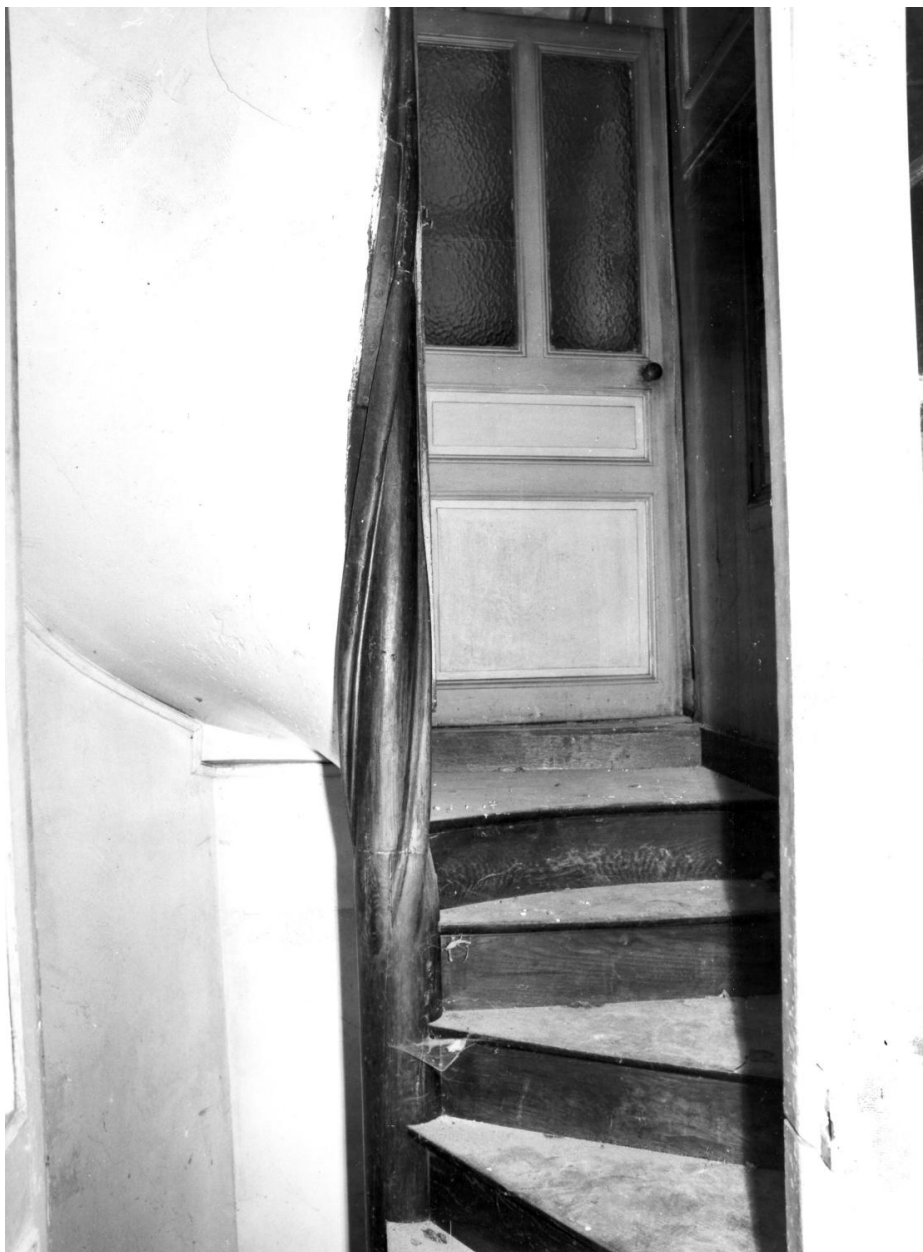
Escalier, 1er palier.
