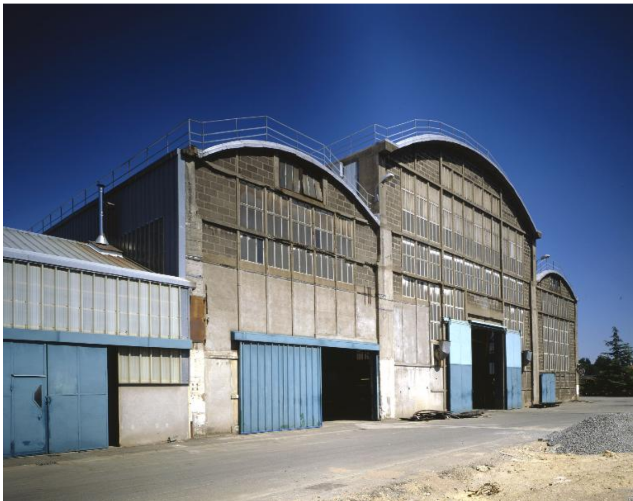
Atelier F : façade sud.
