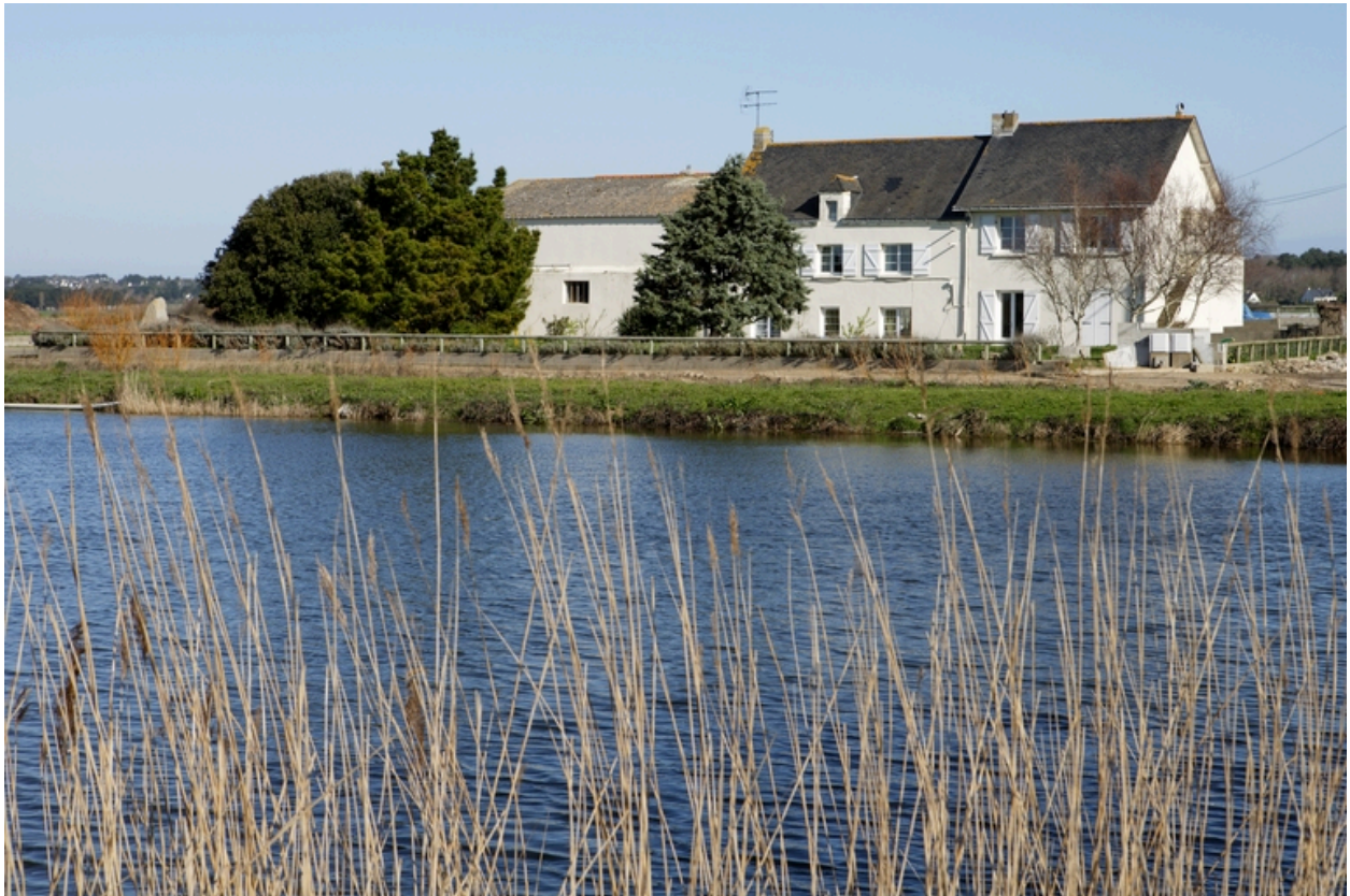
Vue d'ensemble de la rangée depuis le sud.
