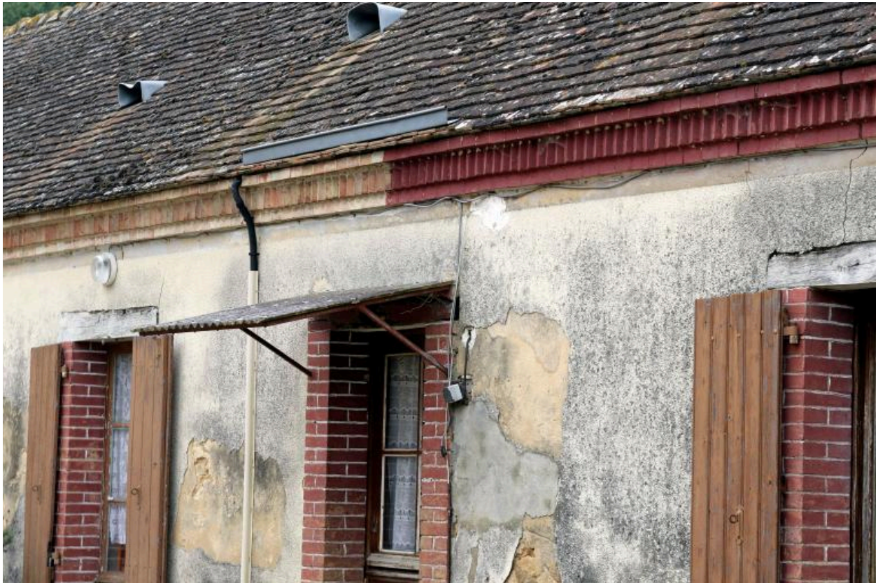
Logis, élévation antérieure : détail de la corniche.
