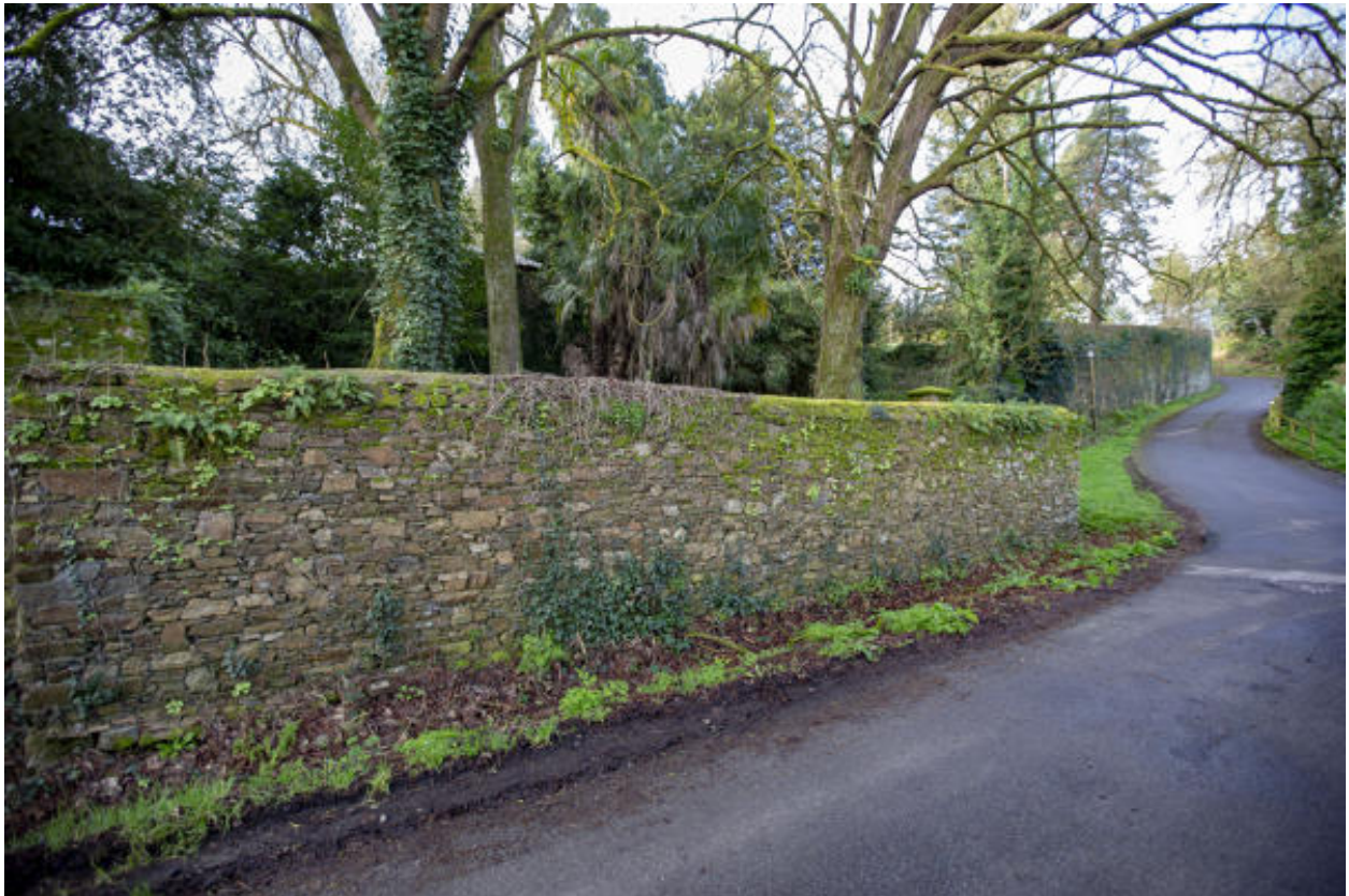
Mur de clôture, rue de la Cale.
