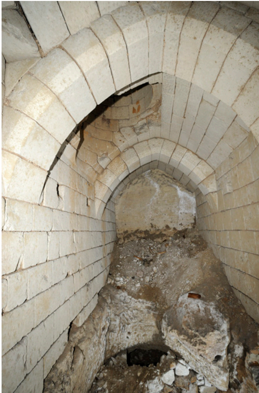
Voûte du palier du second sous-sol : voûte en berceau brisé et doubleaux chanfreinés à clef.
