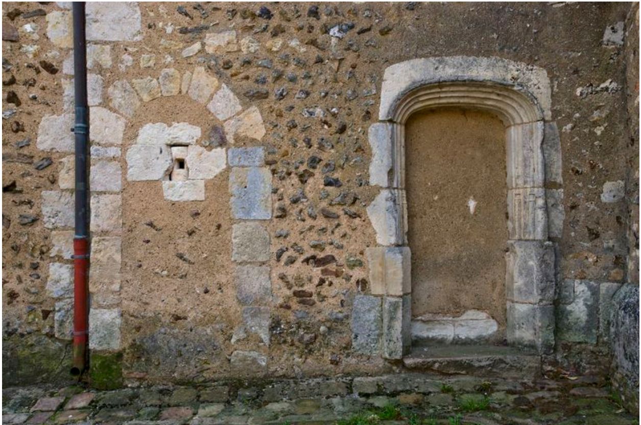
Mur nord du choeur, anciennes portes vers le cimetière
