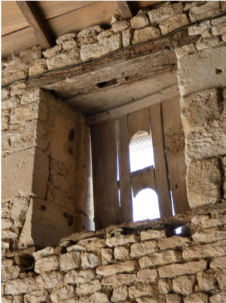
Baie avec boulins à pigeons dans la grange.
