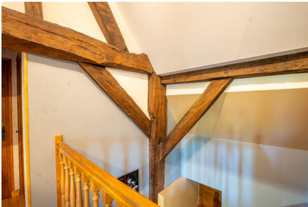
Charpente à poteaux porteurs.
