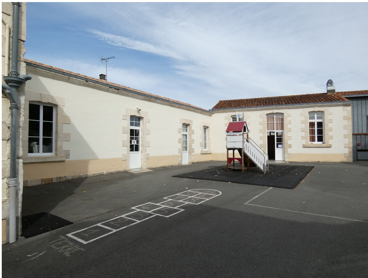
Les deux bâtiments de classes autour de la cour nord, vus depuis le sud.
