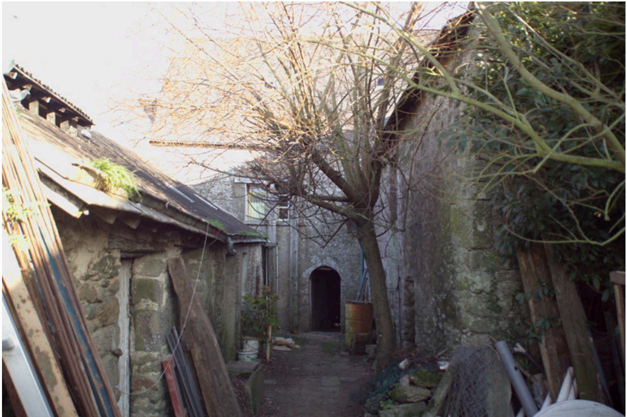
Corps principal, façade sud ; dépendances orientale et occidentale, vue générale.
