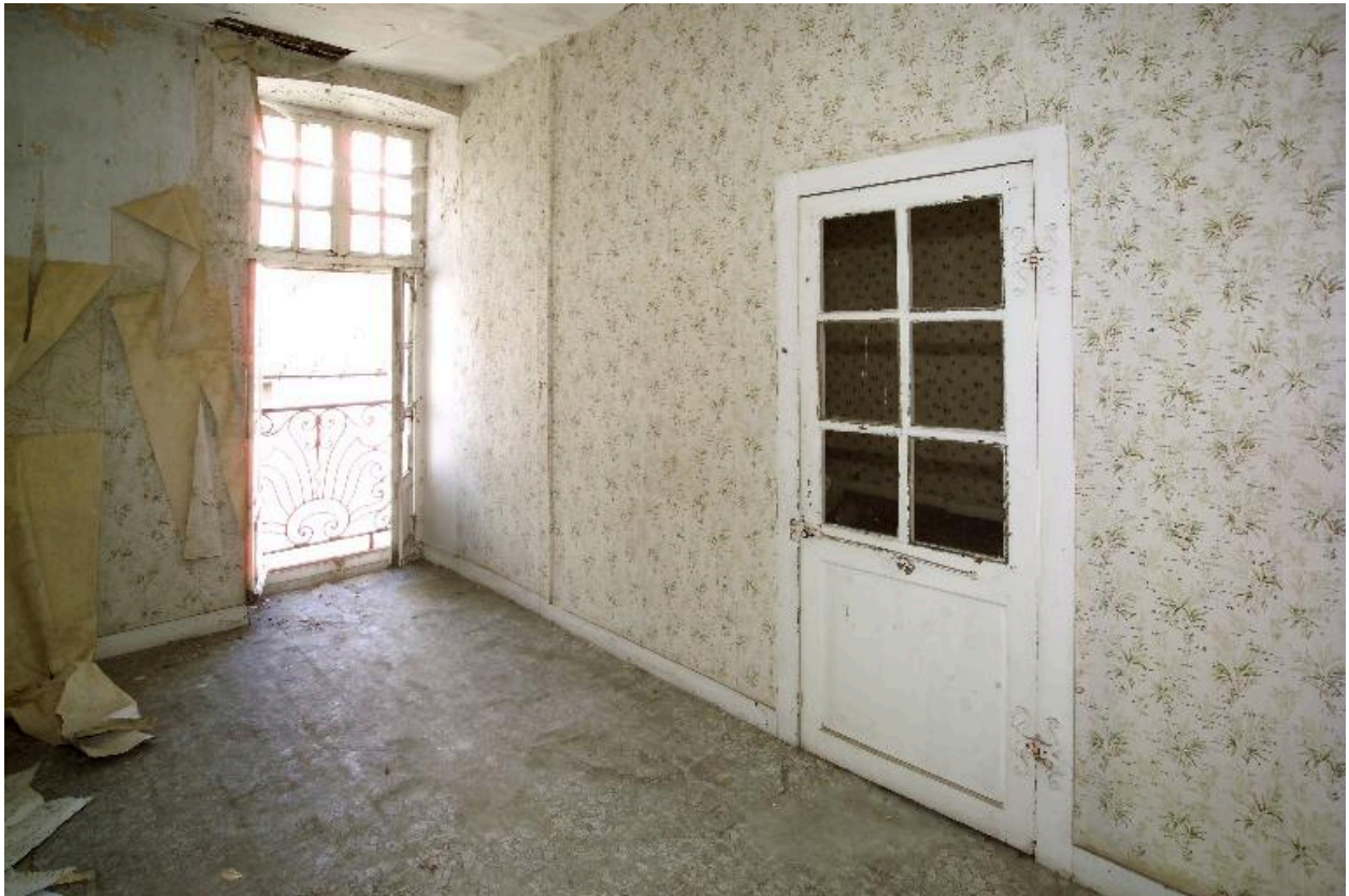
Le corps principal, deuxième étage, la pièce située à l'ouest.
