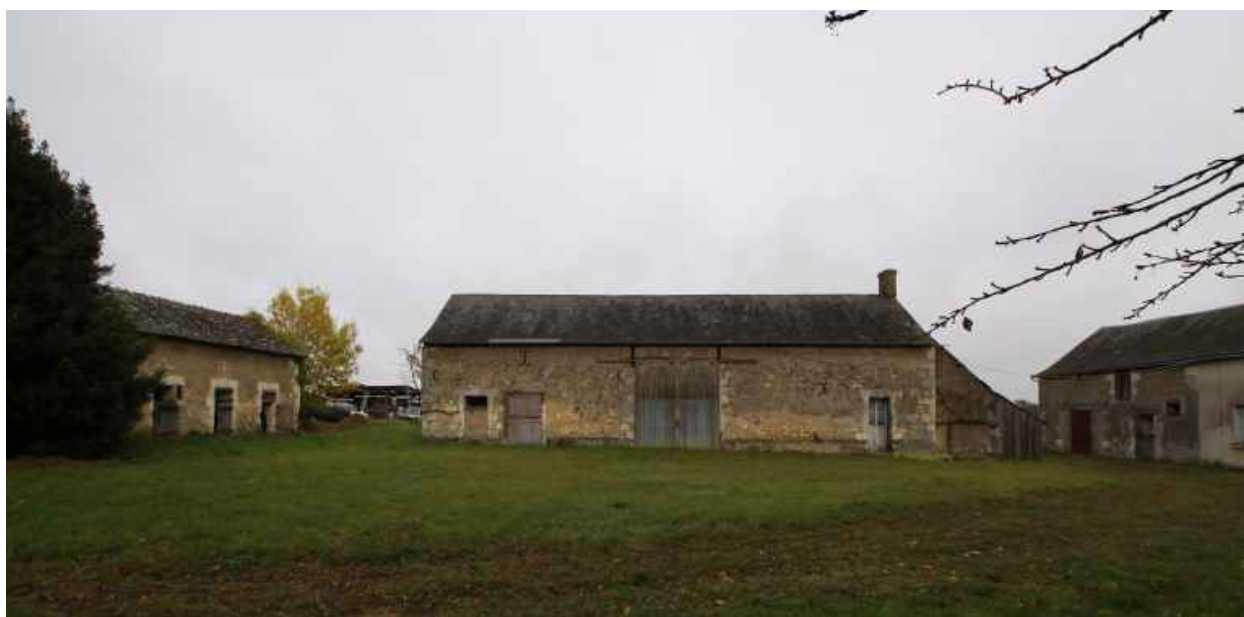
La grange : façade sur cour.
