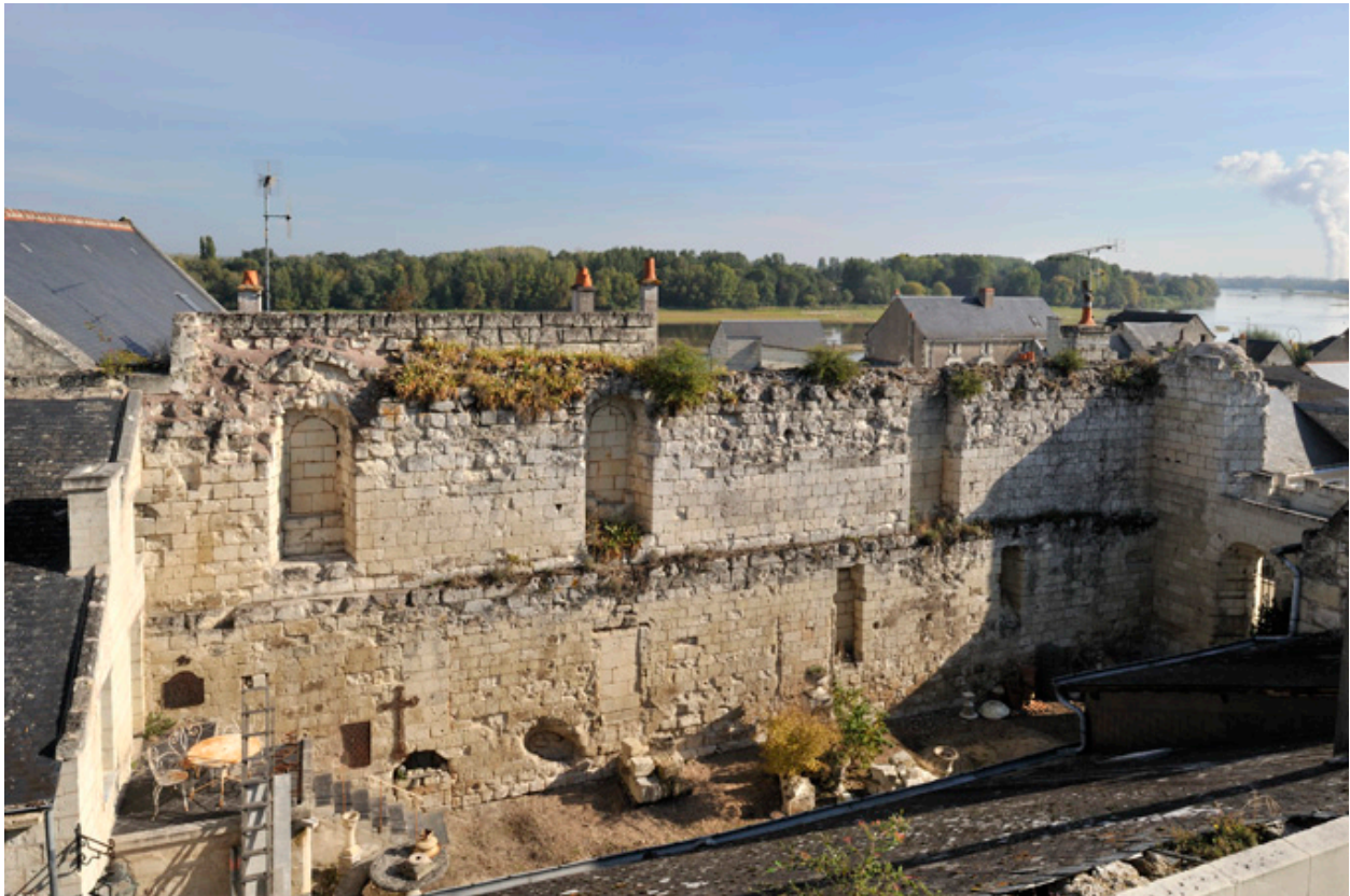
Mur nord, parement intérieur.
