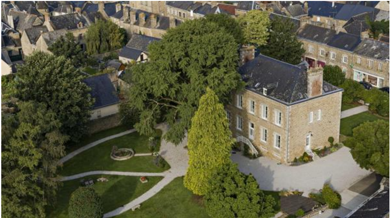
Vue aérienne de la maison du 22 rue du Champ-de-Foire, depuis le nord-est.
