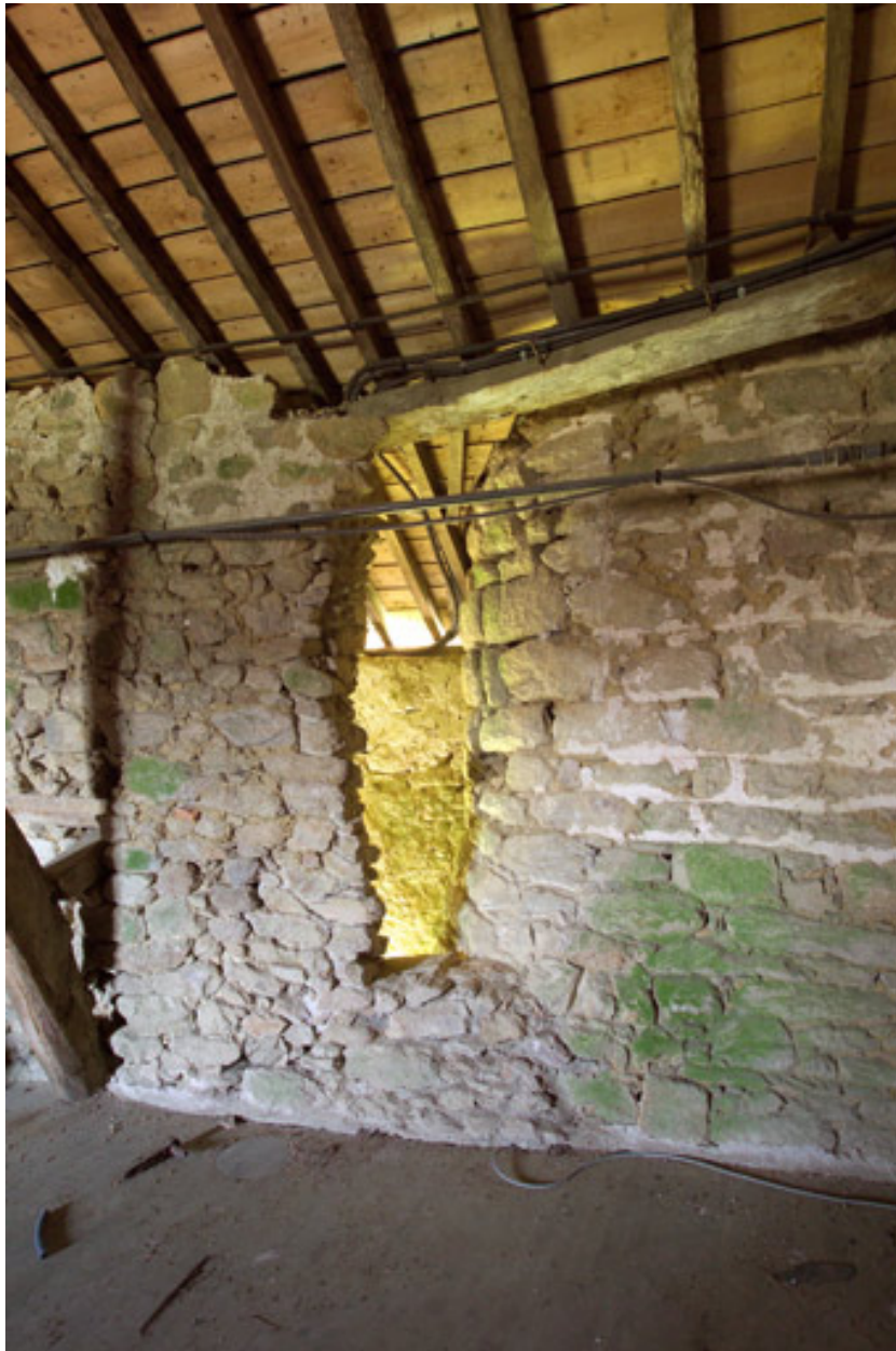
Passage vers le chemin de ronde dans le comble des anciennes écuries.
