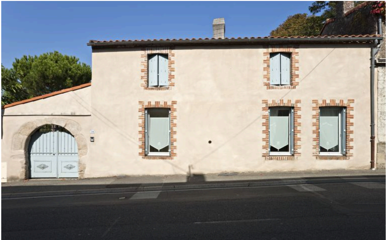
16, rue Sophie Trébuchet : maison reconstruite en 1853, porche fin 18e siècle.
