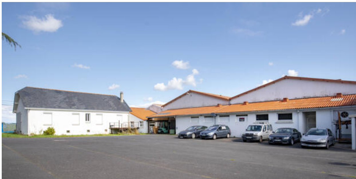
Bureaux et magasins, vue du sud.
