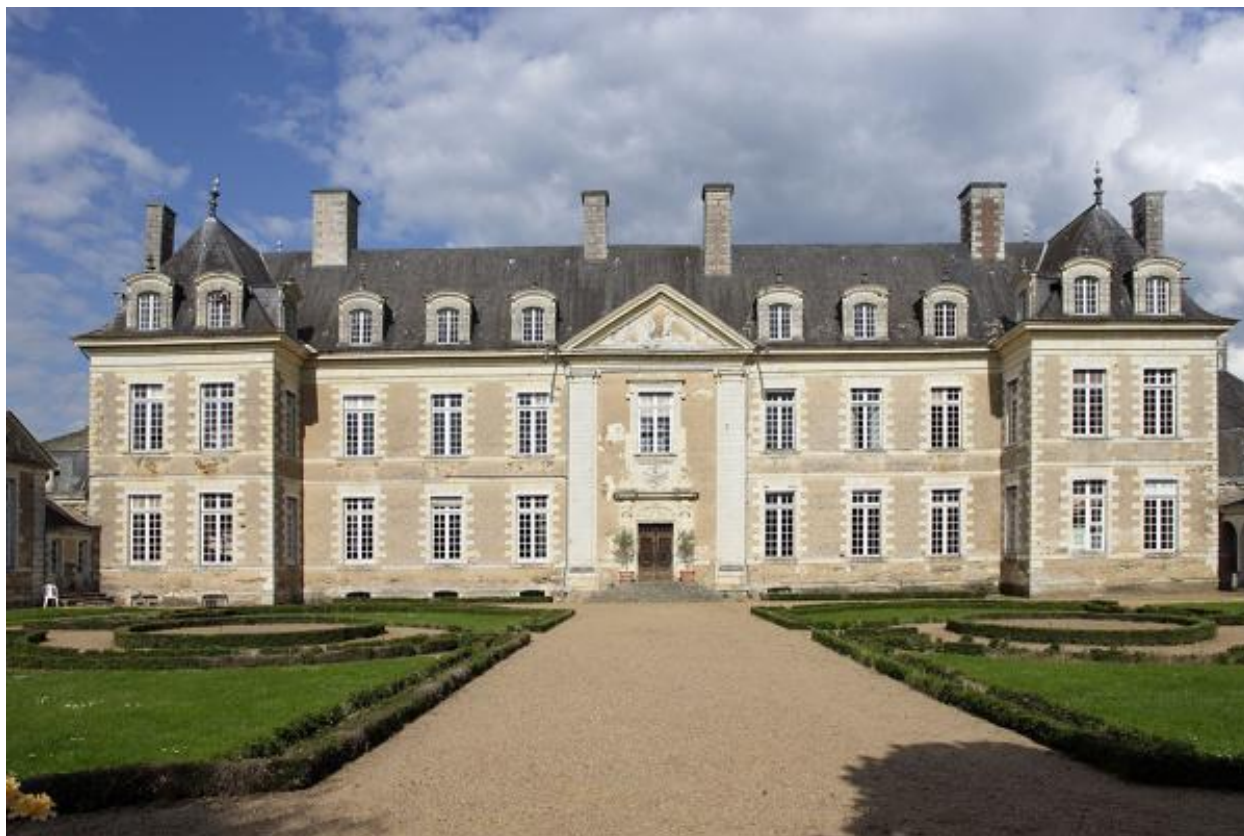
Le logis, élévation ouest.
