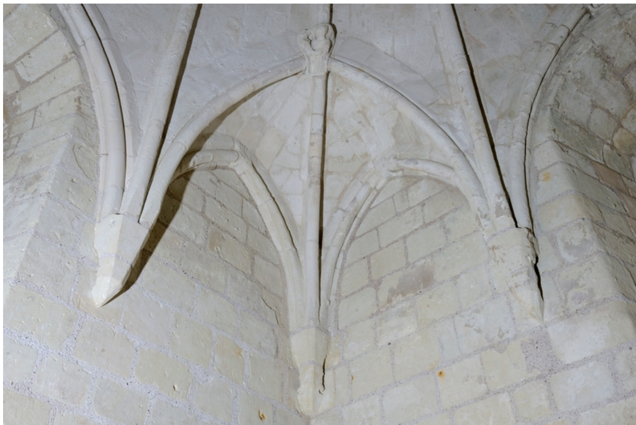
Chapelle haute, voûte, angle sud-est : détail de la trompe (dont clefs à motifs illisibles des formerets).
