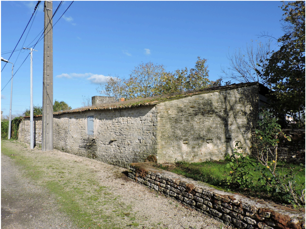
Le fournil, au nord-ouest de la cour, vu depuis le sud-ouest.
