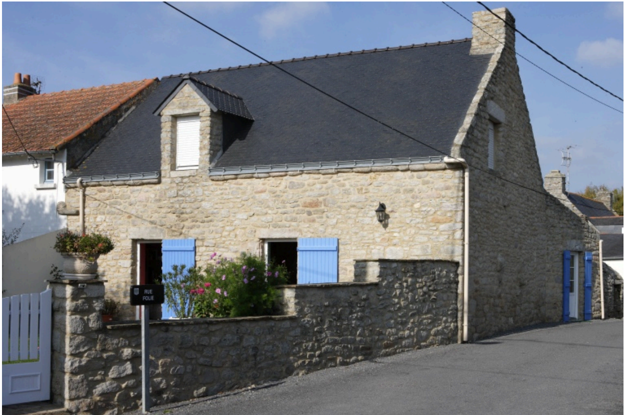
Vue du n° 1 rue Folie depuis le sud-est.
