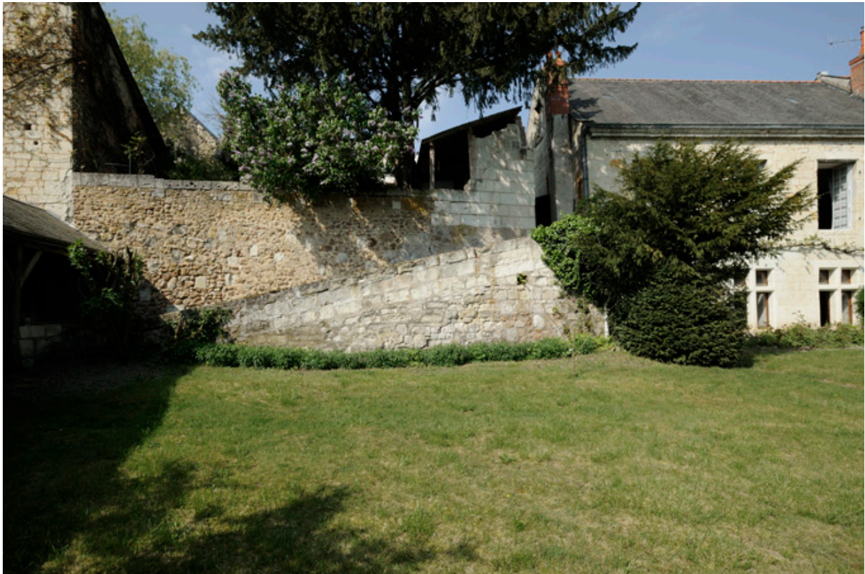
Jardin et rampe d'accès à la cour.
