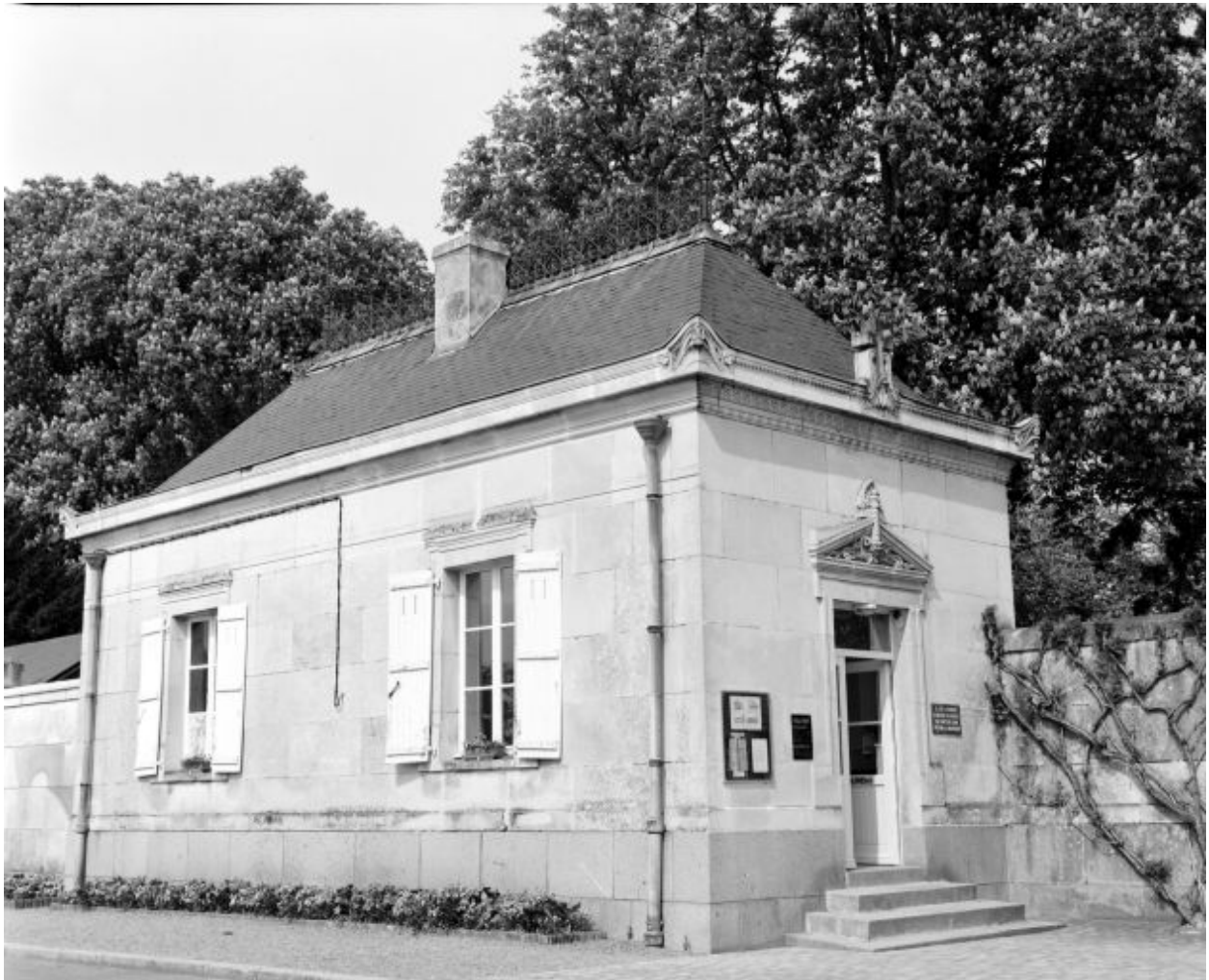
Pavillon d'entrée ouest.
