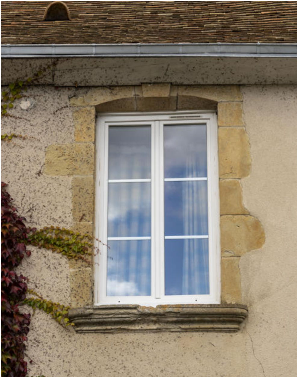
Baie à arc segmentaire délardé de la façade principale.
