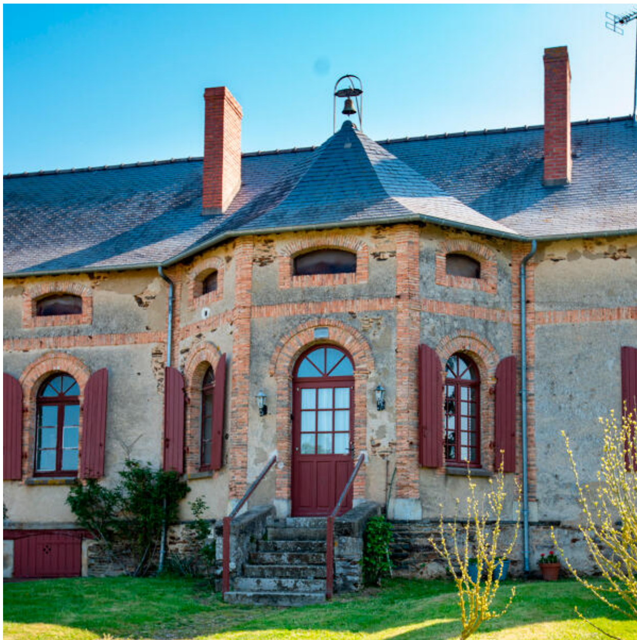
Le logis du fermier, détail de l'avant-corps.
