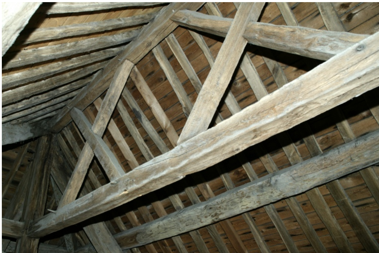
Hôtel Saint Clair, détail de la charpente.
