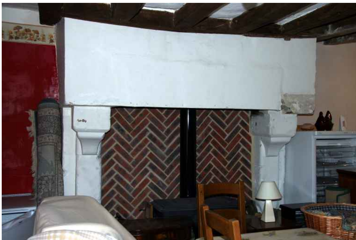
Pignon droit : cheminée.
