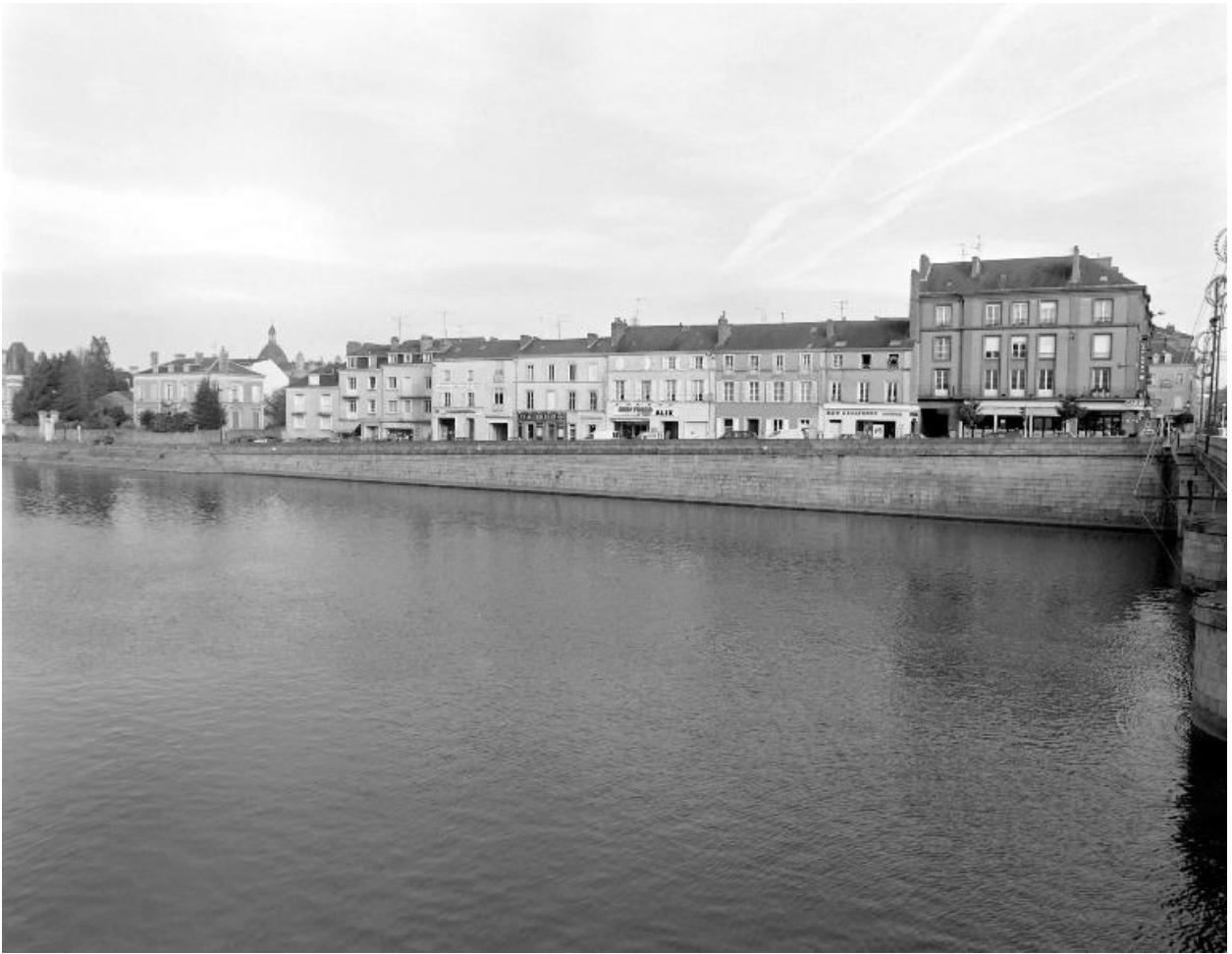
La partie aval du quai Béatrix-de-Gavre, située sur la rive gauche entre le pont de l'Europe et le pont Aristide-Briand, vue depuis ce dernier.
