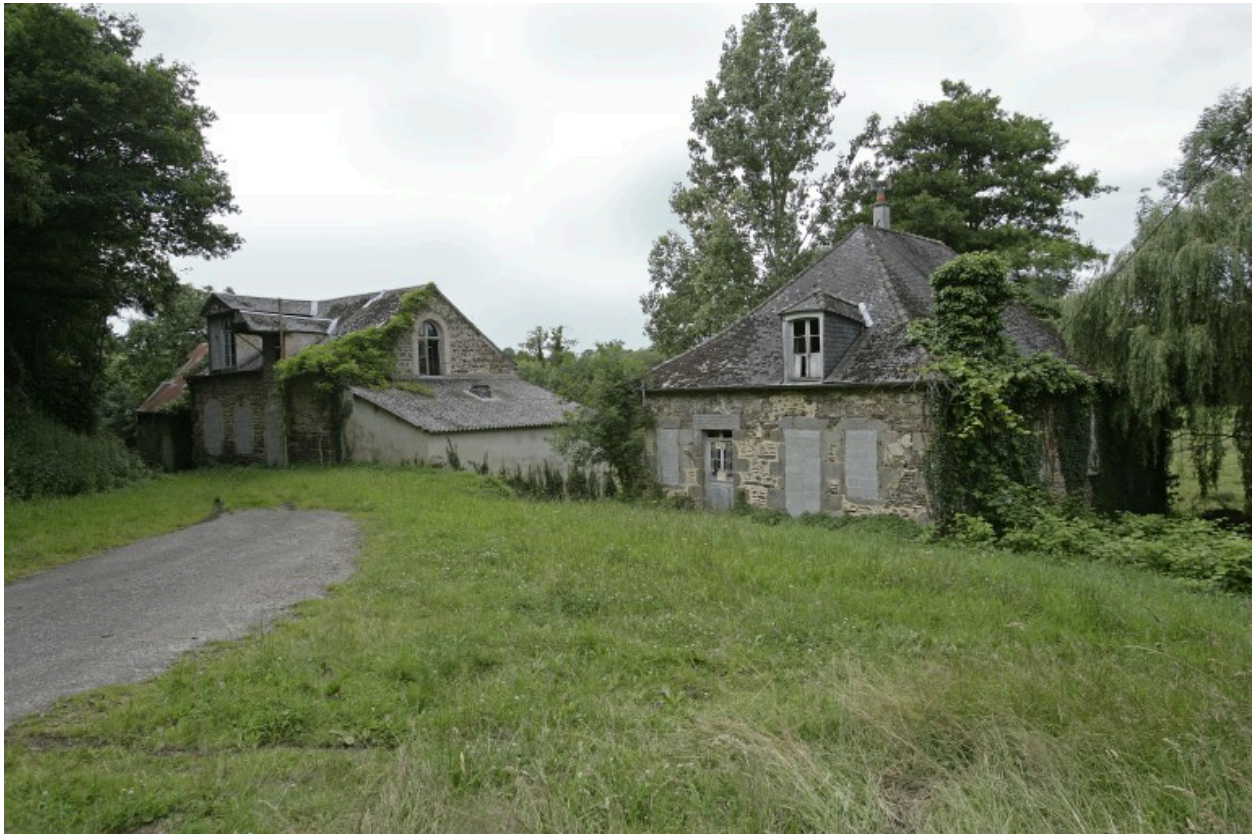
Vue d'ensemble depuis l'est en 2007 : le moulin, la maison.
