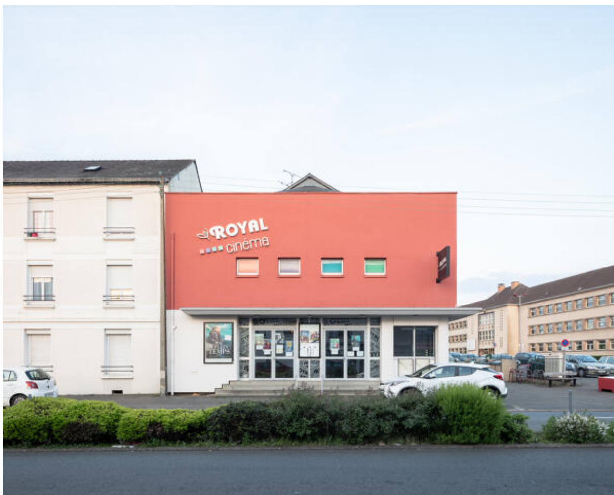
Vue de la façade principale du cinéma.
