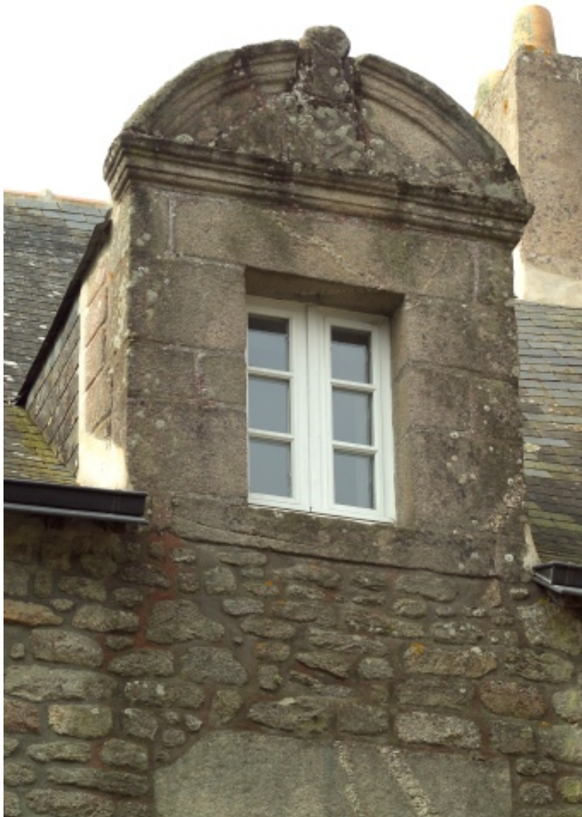
détail de la lucarne ouest de la façade sur rue.
