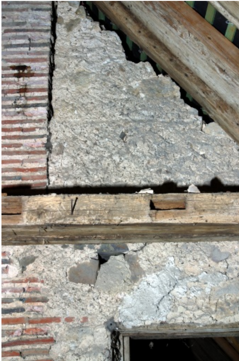
La charpente de la partie sud : détail du faux-entrait en remploi de la ferme nord.
