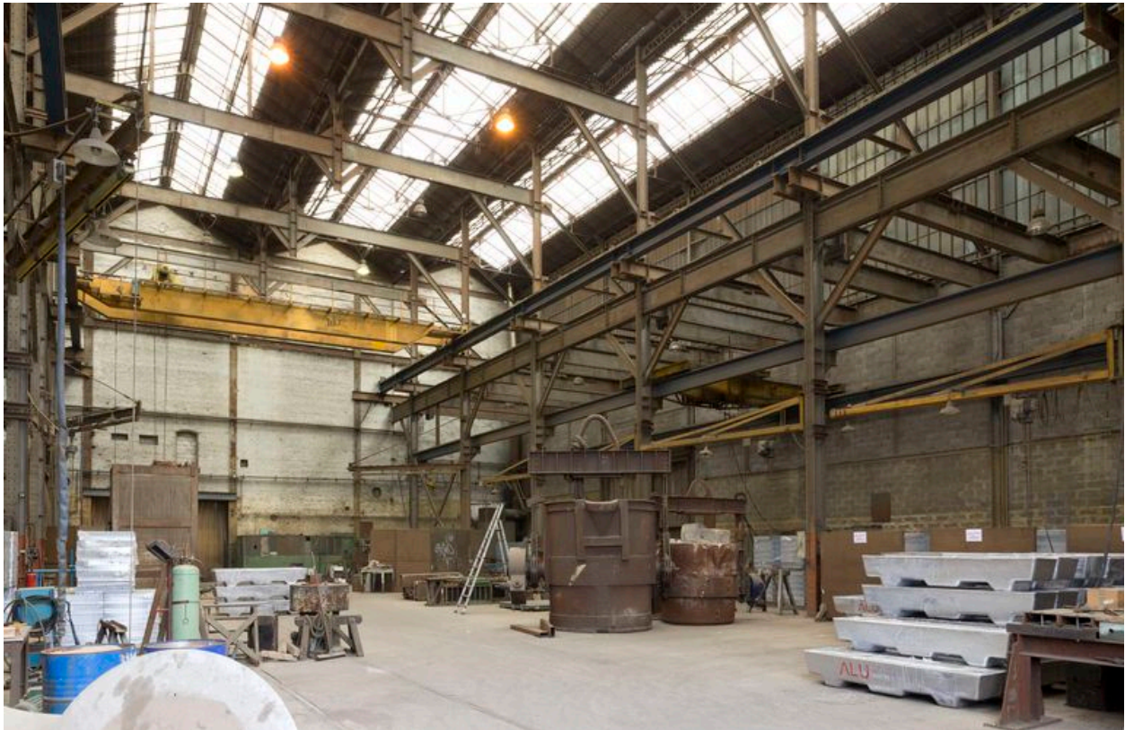
Intérieur de la chaufferie.
