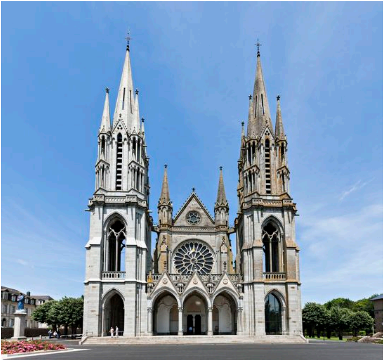
La façade principale vue depuis le sud.
