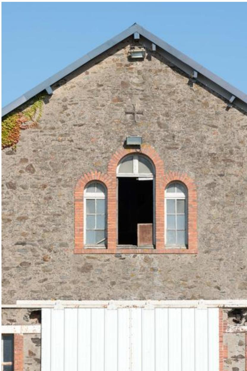
Vue rapprochée de la façade sud de l'usine : un triplet aux encadrements en brique.
