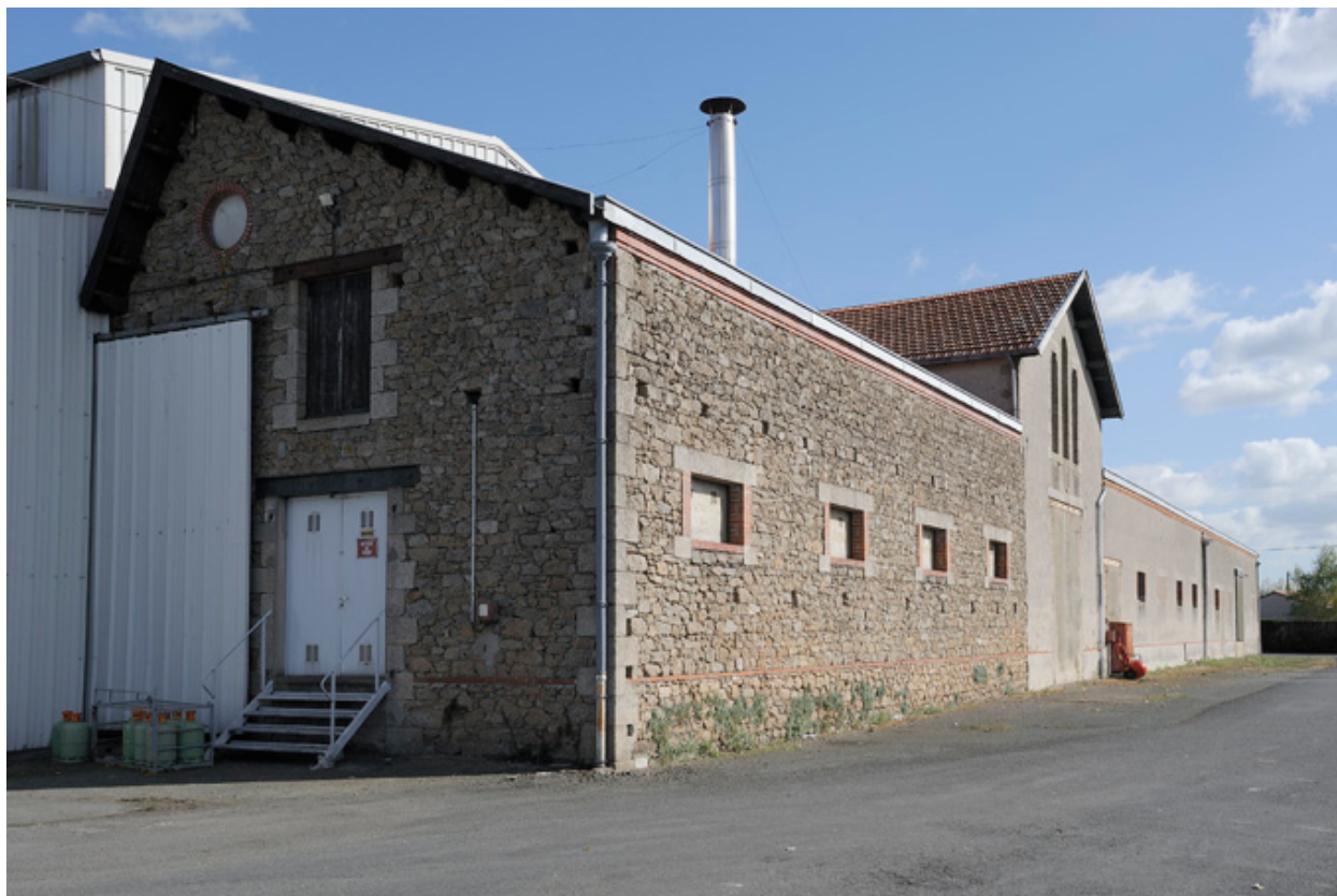
Côté Ouest du bâtiment principal.
