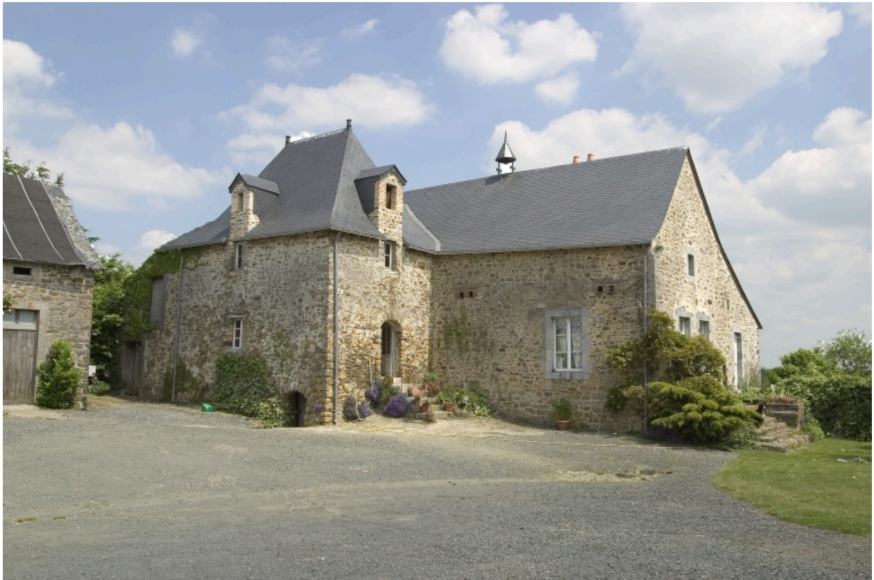
Le logis vu depuis l'ouest.
