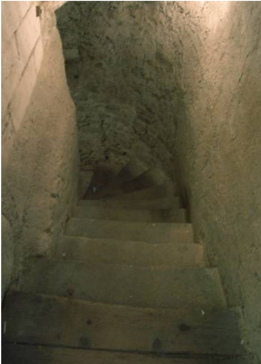
Vue de l'escalier en pierre conduisant à la cave.
