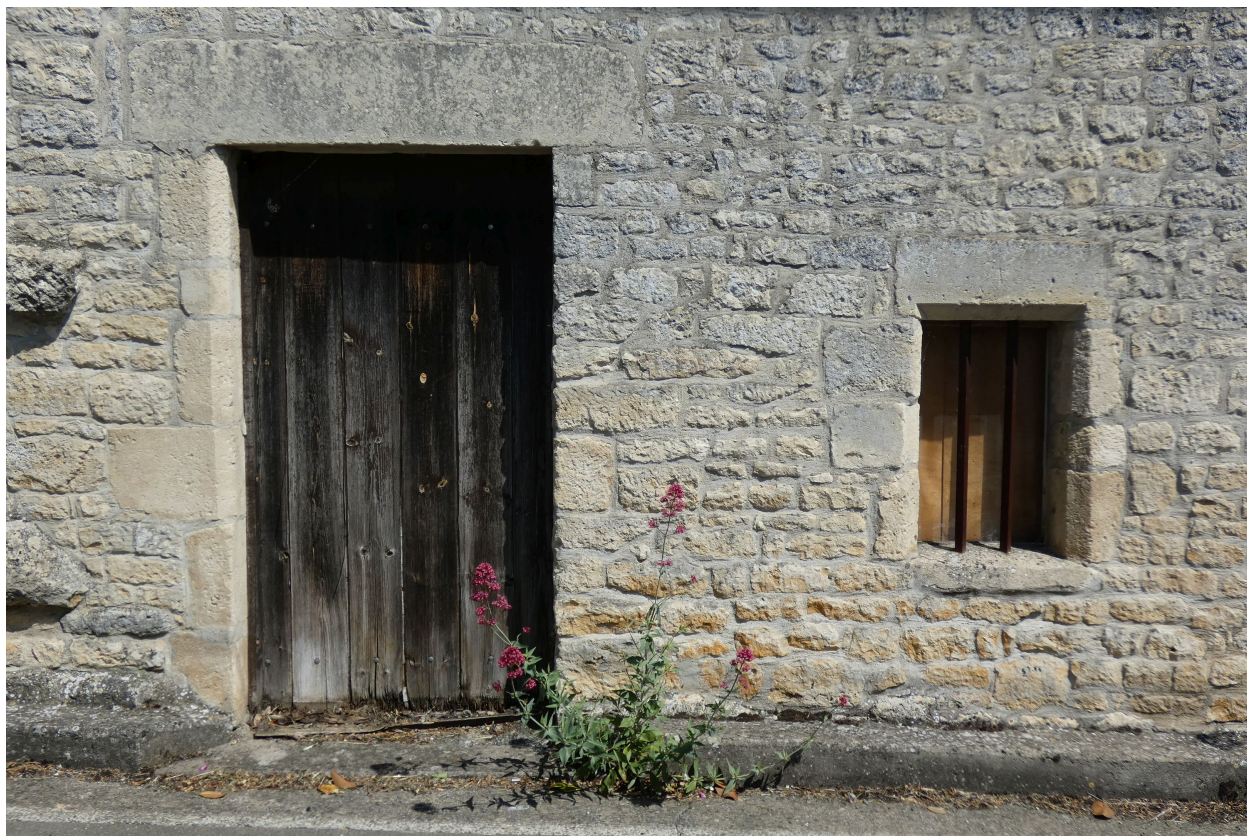
Porte et baie à encadrement chanfreiné sur la façade sud de la dépendance.
