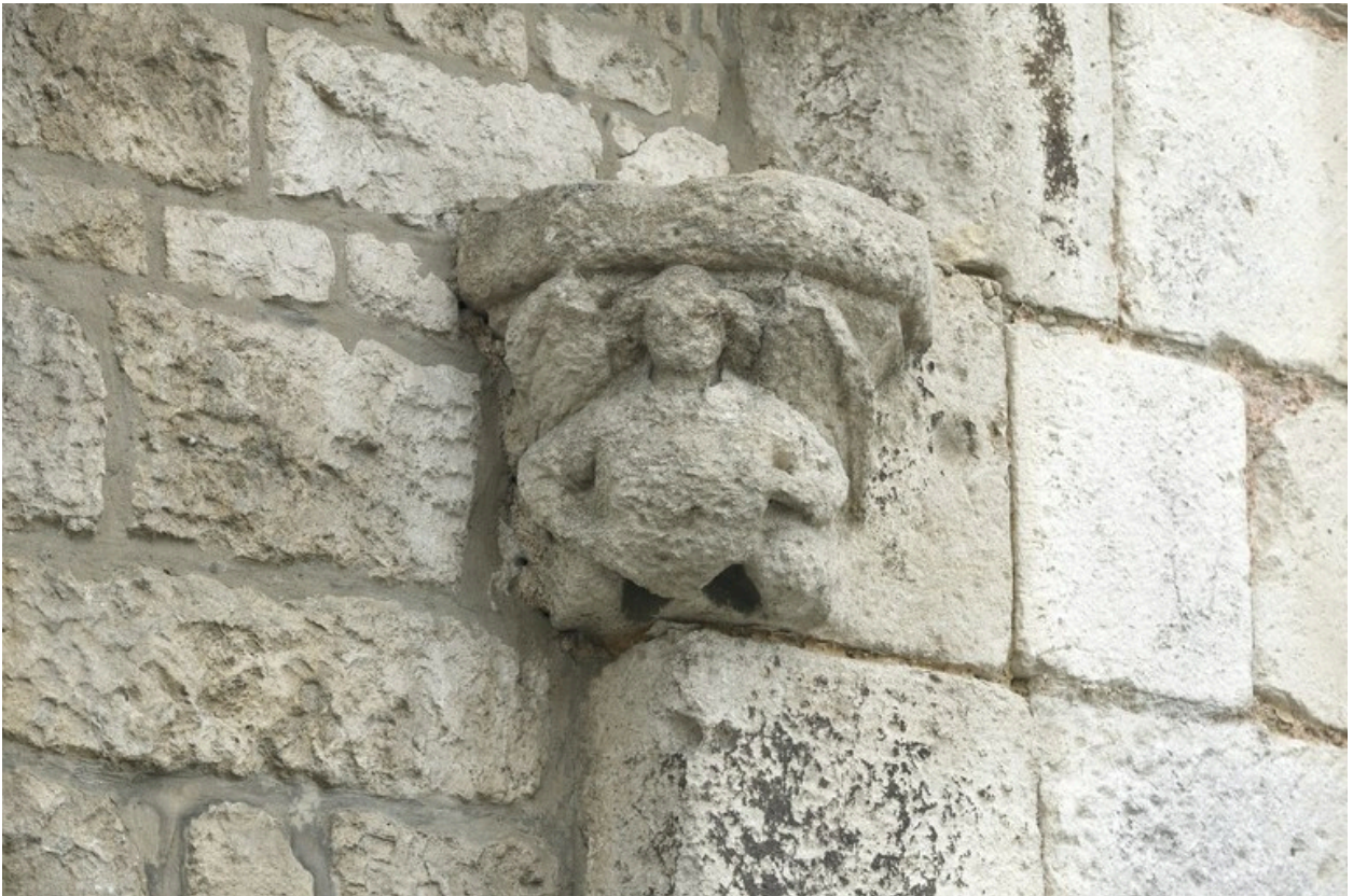
Culot avec un ange portant un écu, à l'angle nord-est de la chapelle.
