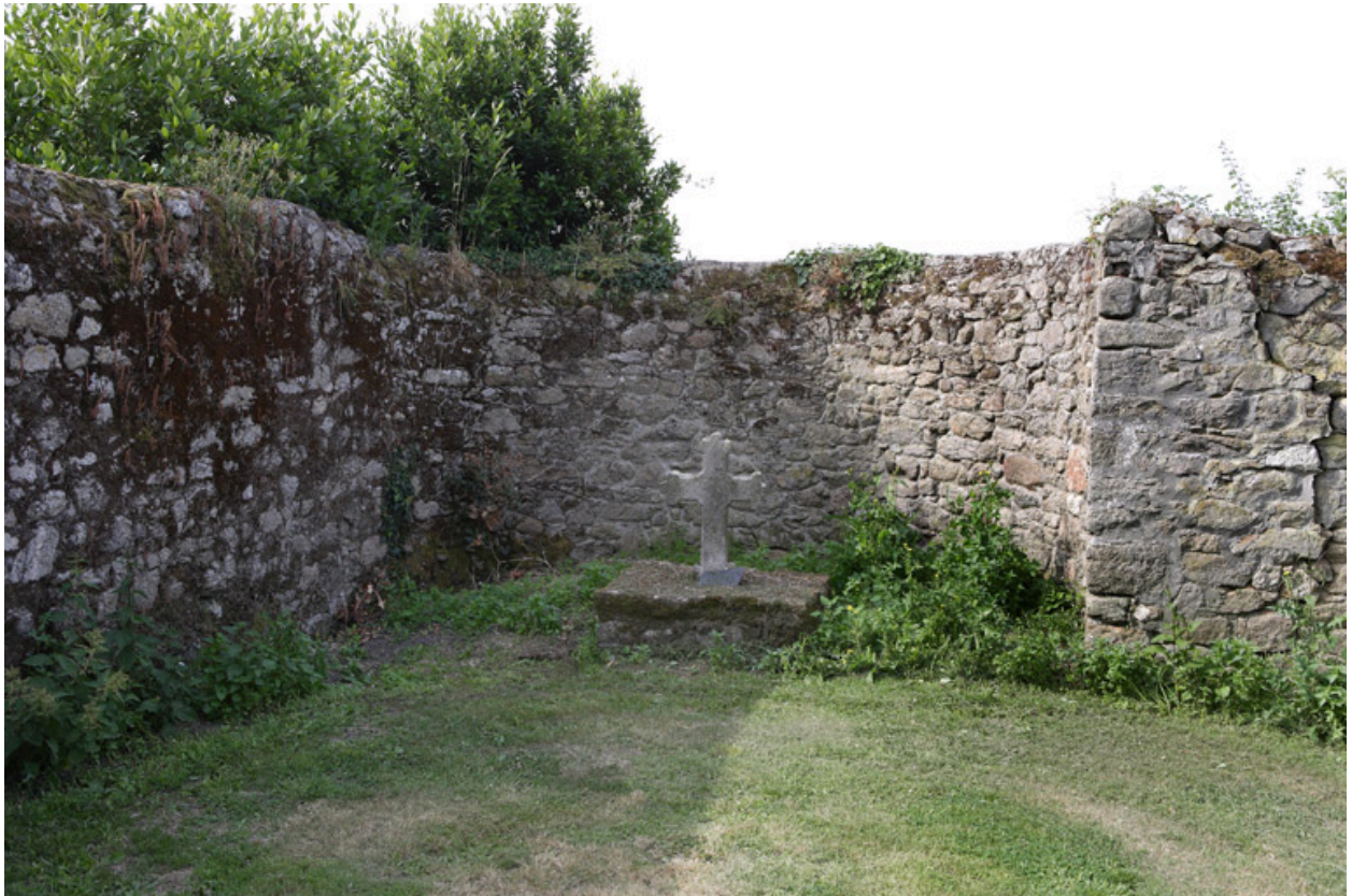
Mur de clôture. Détail de la tourelle dans l'angle sud-est.
