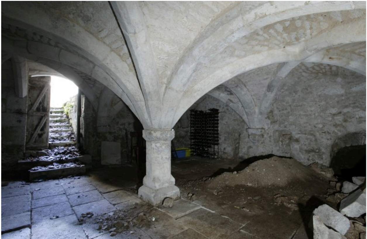
Sous-sol situé sous le bâtiment en fond de cour.
