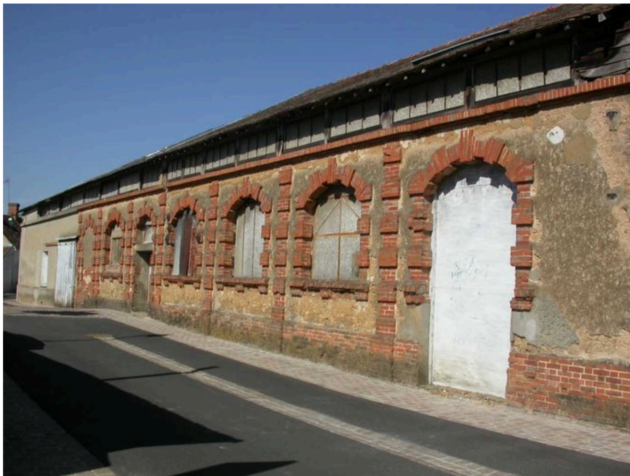
Le mur-gouttereau de l'usine côté rue, 2005.
